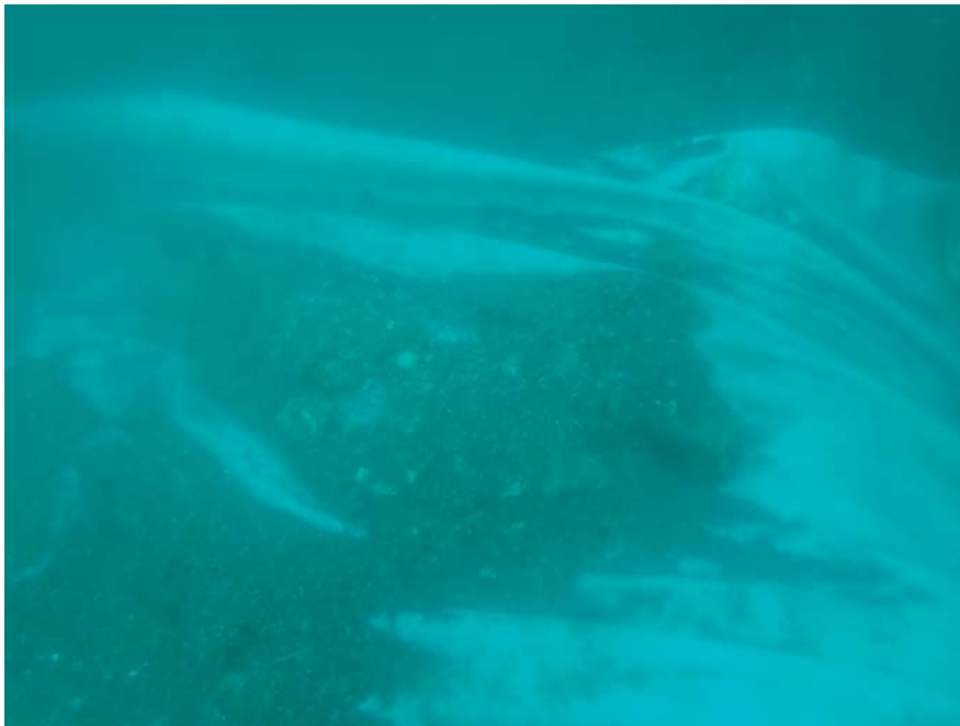
fig. 19 – Sondage n° 1 en cours de couverture avec un géotextile, puis une épaisse couche de sédiments (photo D. Besse/ARESMAR)
